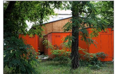
Duschkabinen von außen
